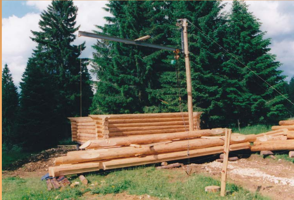
Différentes étapes du montage de la cabane
